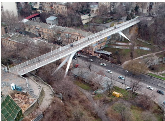
Рис. 1. Загальний вид мосту
